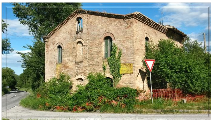
Edificio al bivio di Pintura del Grillo (Cessapalombo).
