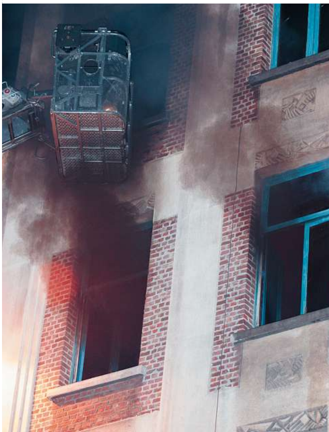
oben: Der Angriffstrupp klettert vom Rettungskorb der Drehleiter »Zuid« in die Räume des vierten Obergeschosses. unten: Aus dem dritten Obergeschoss tritt plötzlich intensiv Brandrauch aus.
