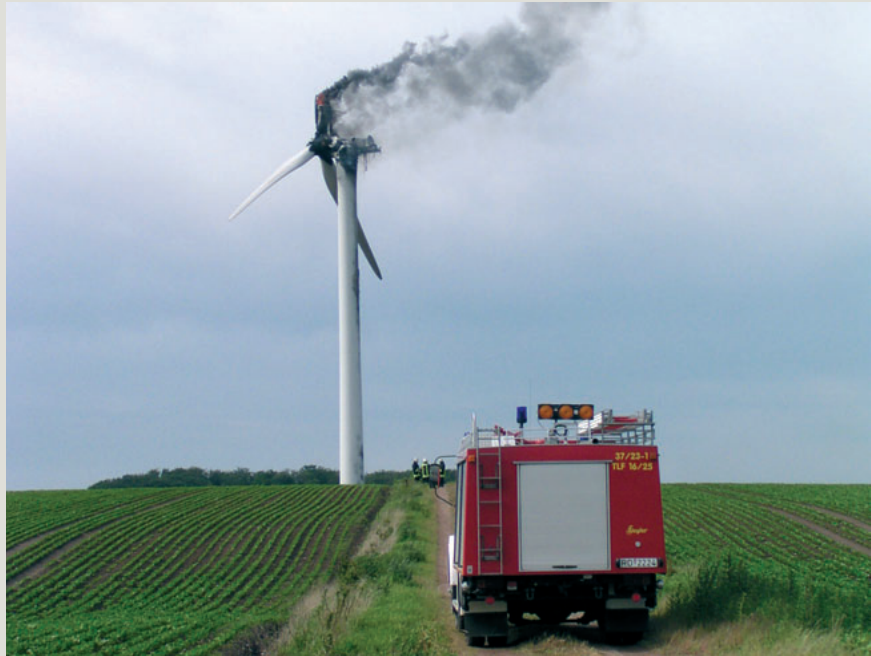
Beim Brand in der Windenergieanlage: Abstand halten! (Foto: H. Bauer)
