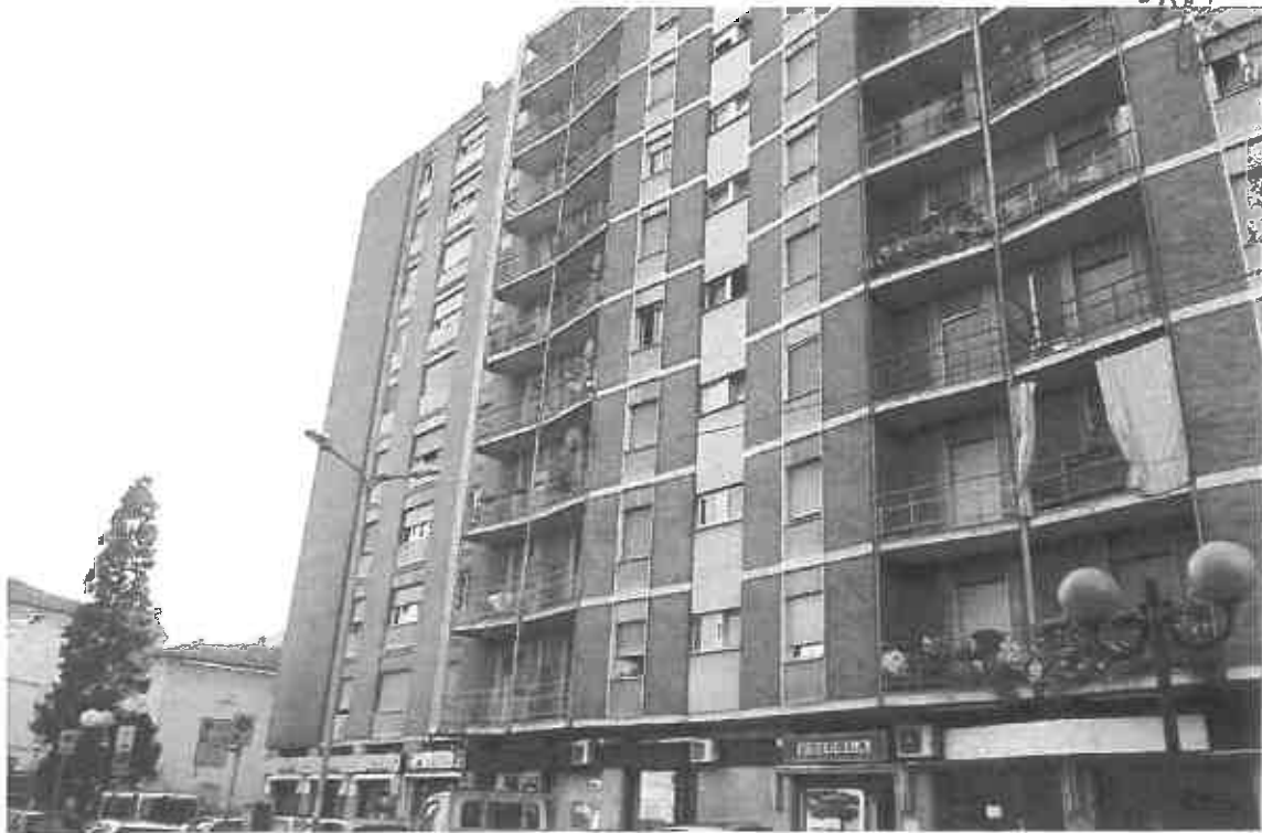
FOTO N. 2 - ALTRA VEDUTA INTERO FABBRICATO
