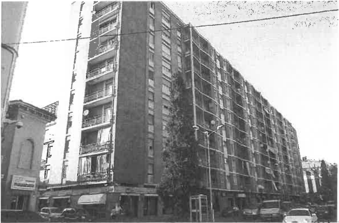
FOTO N. 1 VEDUTA INTERO FABBRICATO
