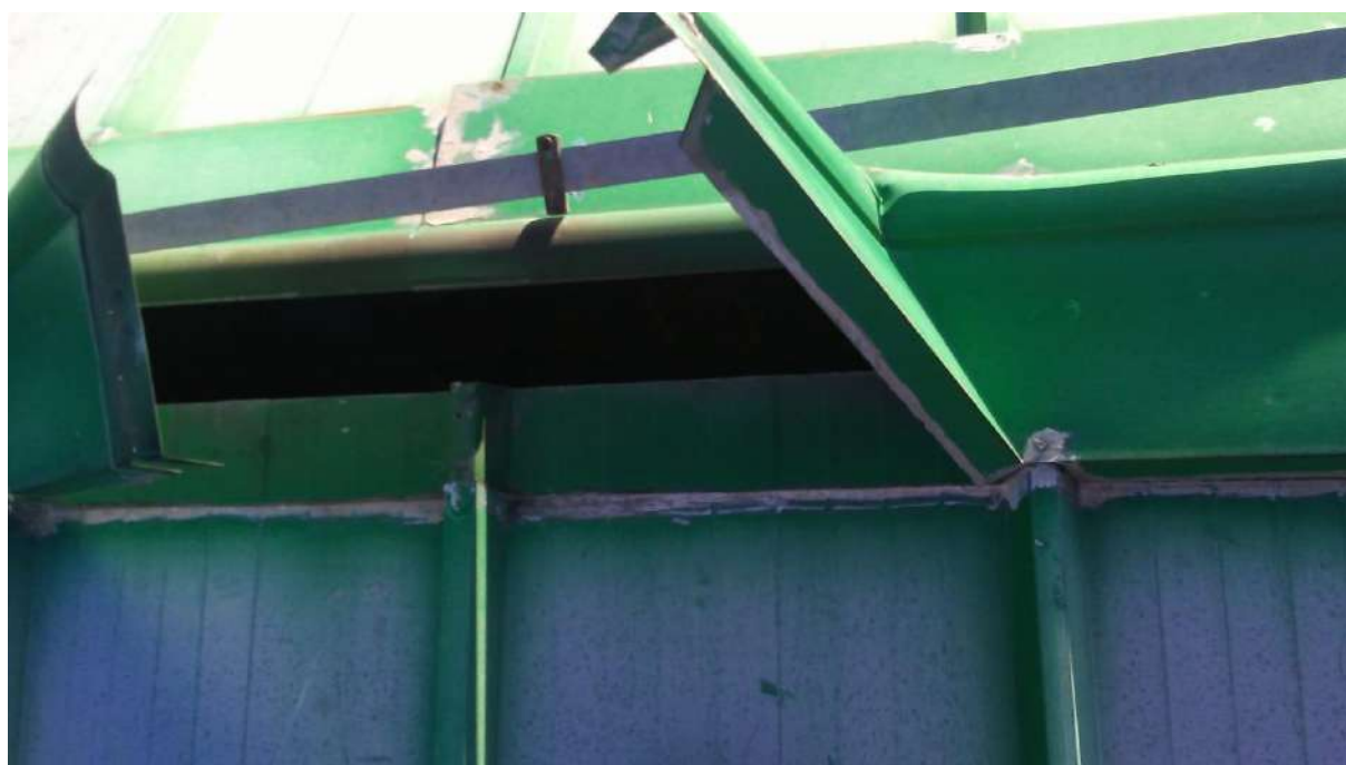
Danni alla copertura in seguito al forte vento in data 14.12.2019
