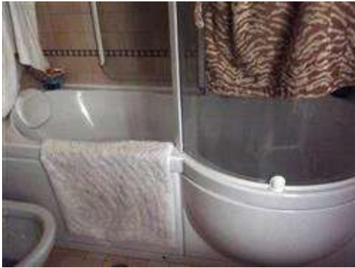
Igienico -sanitari del bagno
