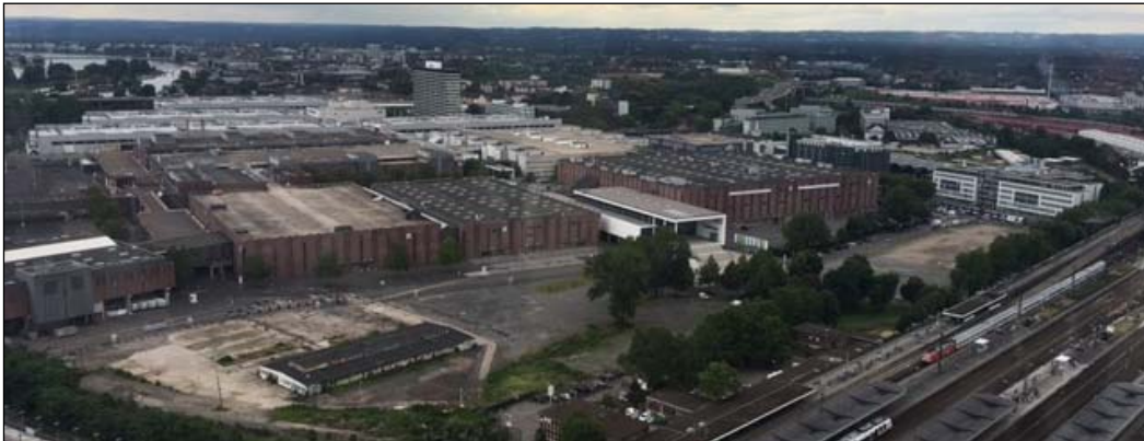
Köln-Deutz. Neben der Messe entsteht die neue Zentrale der Zurich-Versicherung . Sie mietet hier rund 60.000 Quadratme-
