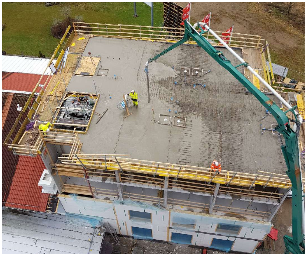
Bygget av nya Best Western Hotel sett från ovan
