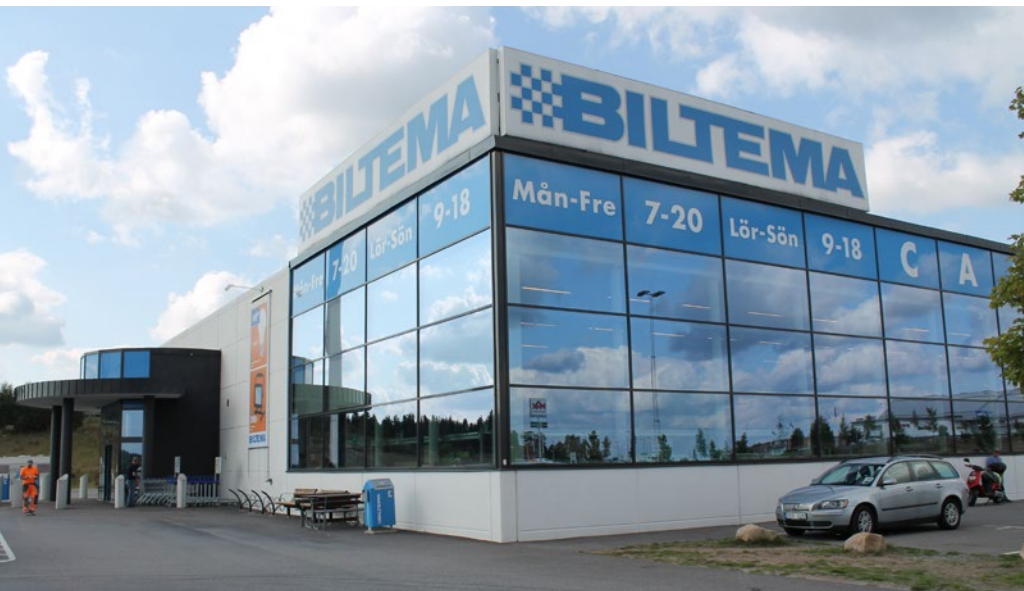
Biltemas anläggning i Ljungby, byggd av Lagans Byggnads AB
