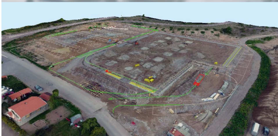
En byggnadstomt fotograferad av en drönare
