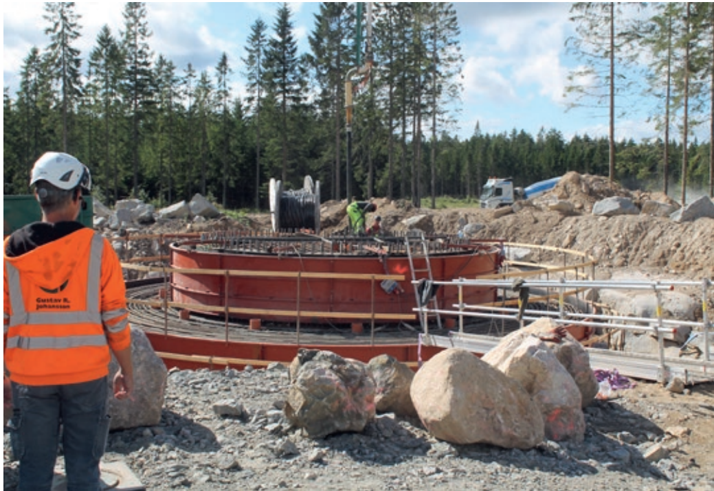
Tillverkning av ett av de bergförankrade fundamenten.
