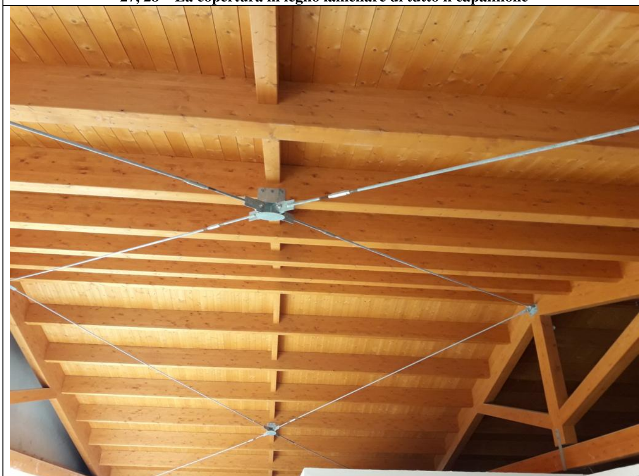
27, 28 – La copertura in legno lamellare di tutto il capannone
