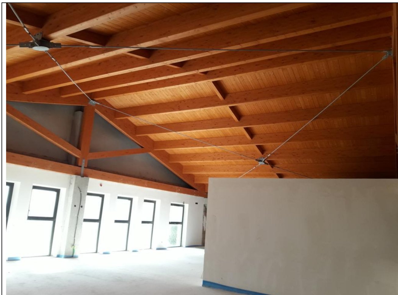
27, 28 – La copertura in legno lamellare di tutto il capannone
