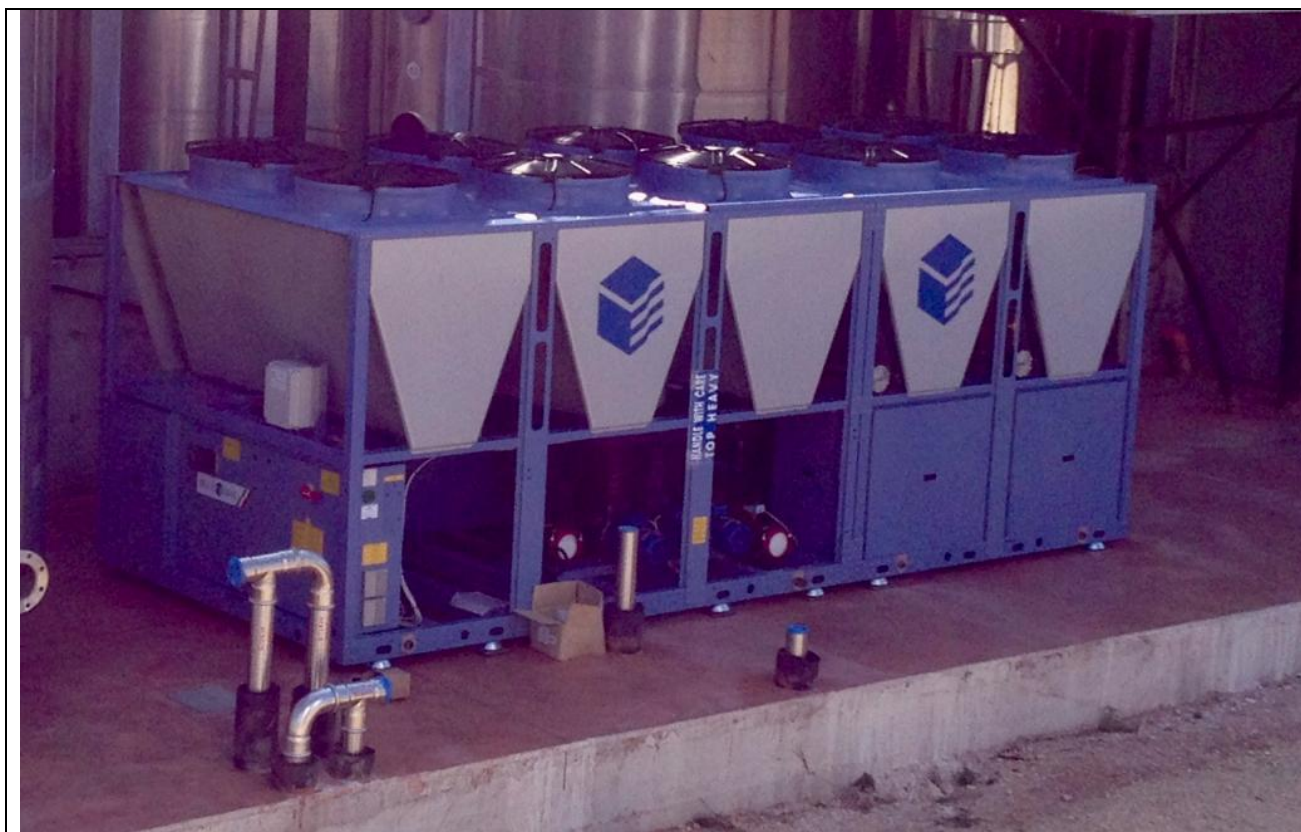
152 – Impianto di refrigerazione e termo condizionamento dei mosti e dei vini BLUE BOX (h)
