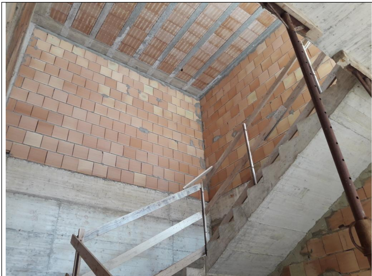
33 – Rampa di scale che porta al primo piano in corso di costruzione
