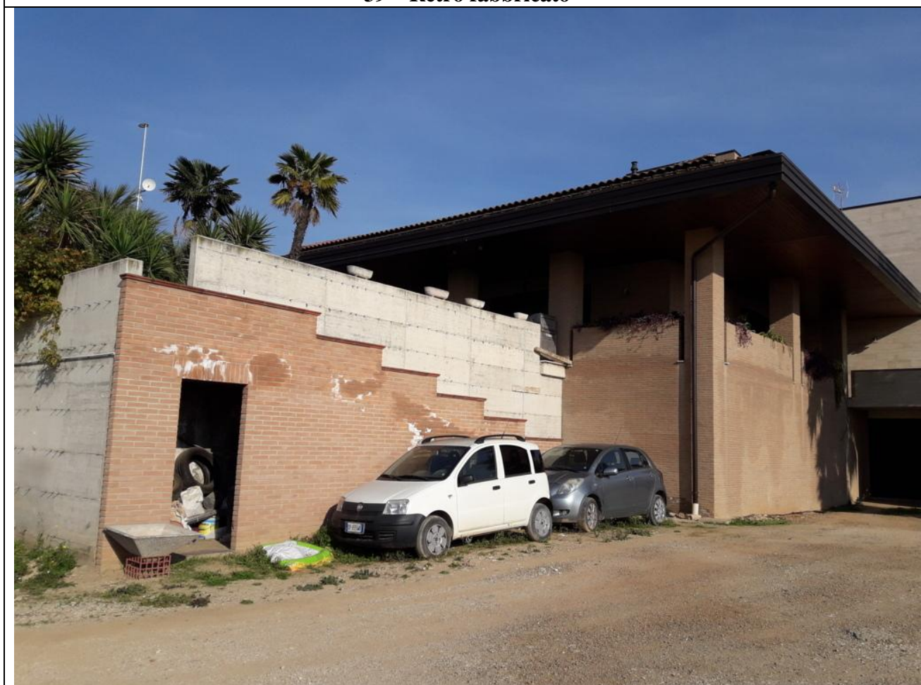
40 – Contrafforte con sottostante vano scala
