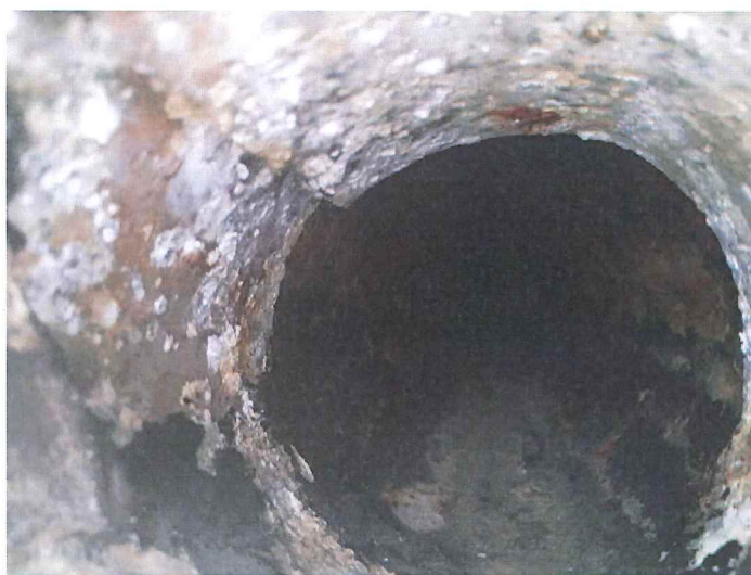
Bazén - výměna potrubí
