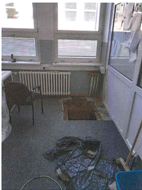
Havárie - výměna rozvodů topení
